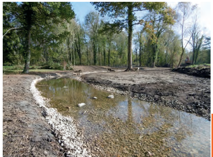
Après les travaux
