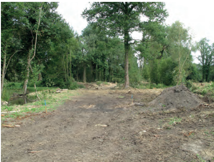
Pendant les travaux
