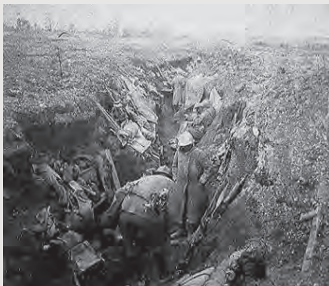
Dans les tranchées
