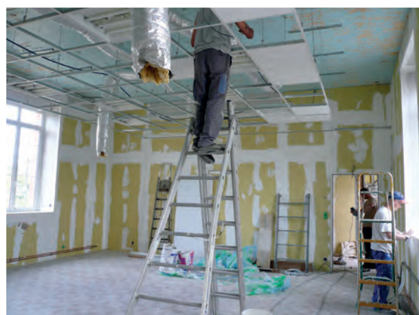
Les plaquistes à l'ouvrage
